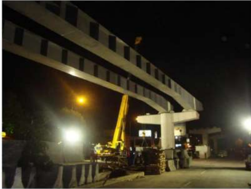
OBRA PUENTE VEHICULAR CHURUBUSCO SECTOR PÚBLICO
