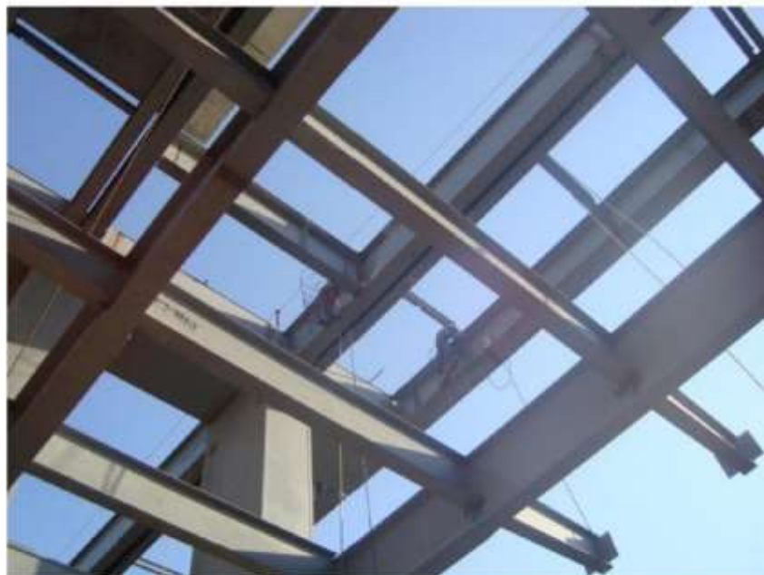
OBRA ACCESO SUR METRO LINEA 12 SECTOR PÚBLICO
