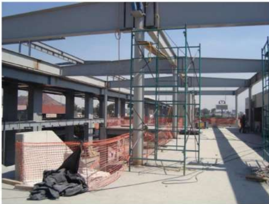
OBRA ESTACION PERIFERICO ORIENTE SECTOR PÚBLICO
