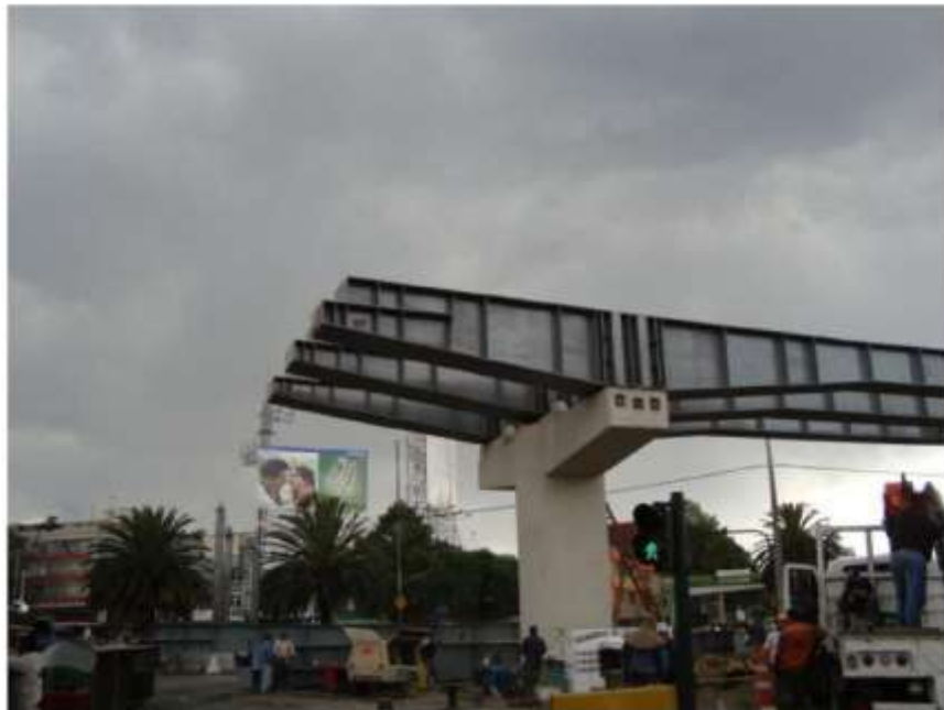
OBRA PUENTE VEHICULAR PERIFERICO SECTOR PÚBLICO
