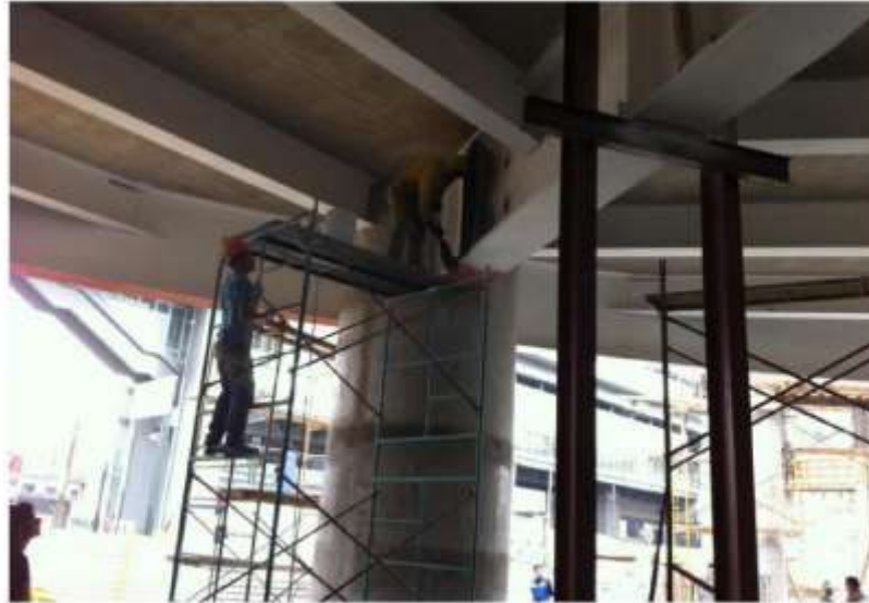
OBRA CETRAM SECTOR PÚBLICO
