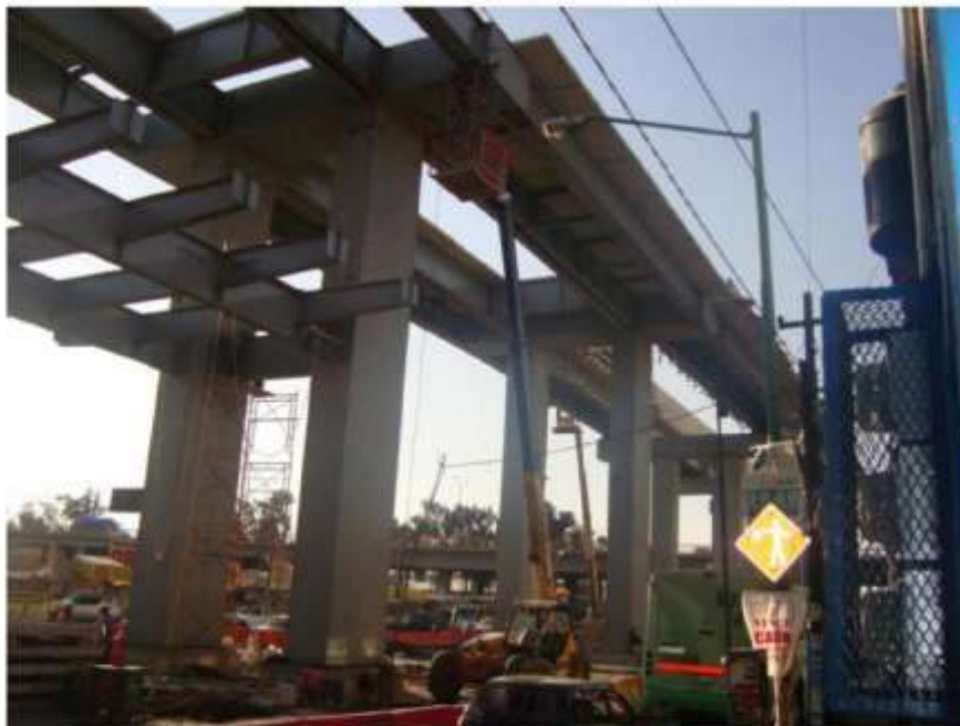
OBRA ACCESO SUR METRO LINEA 12 SECTOR PÚBLICO
