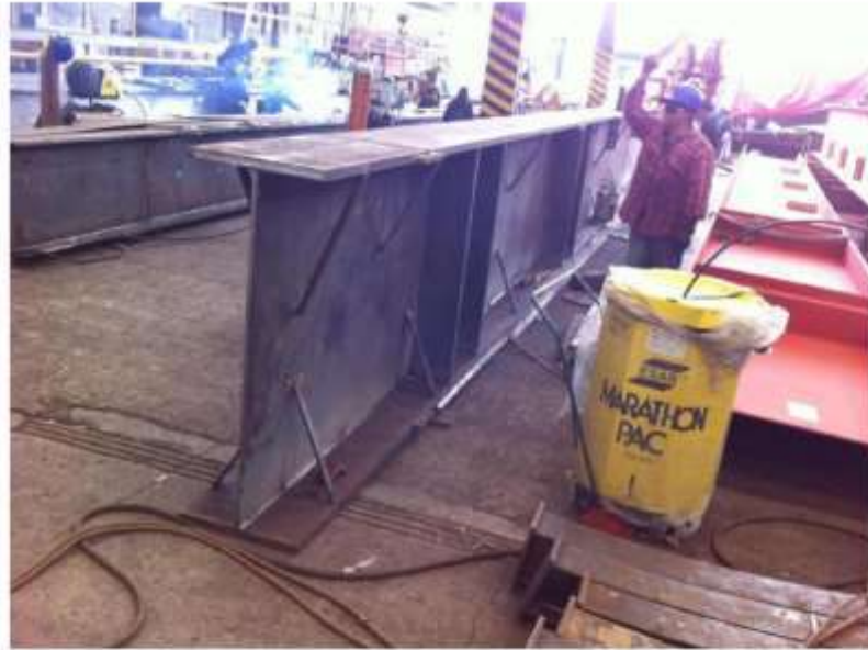
OBRA PUENTE VEHICULAR TOREO SECTOR PÚBLICO
