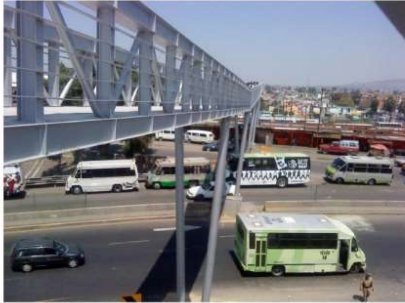
OBRA PUENTE PEATONAL SECTOR PÚBLICO
