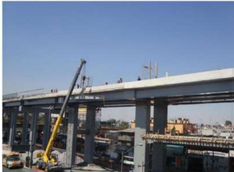
OBRA ESTACION PERIFERICO ORIENTE SECTOR PÚBLICO
