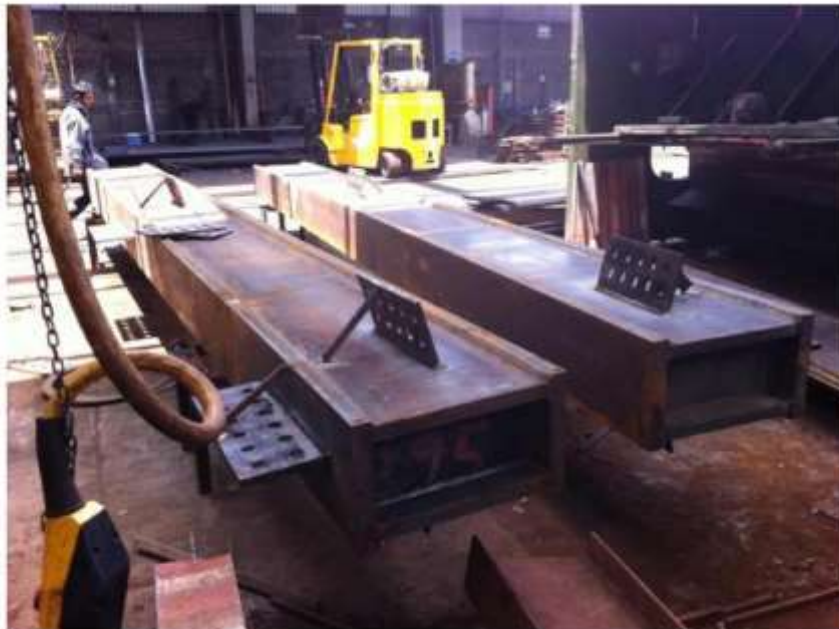
OBRA CETRAM SECTOR PÚBLICO
