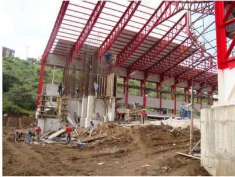
OBRA ALBERCA OLIMPICA SECTOR PÚBLICO
