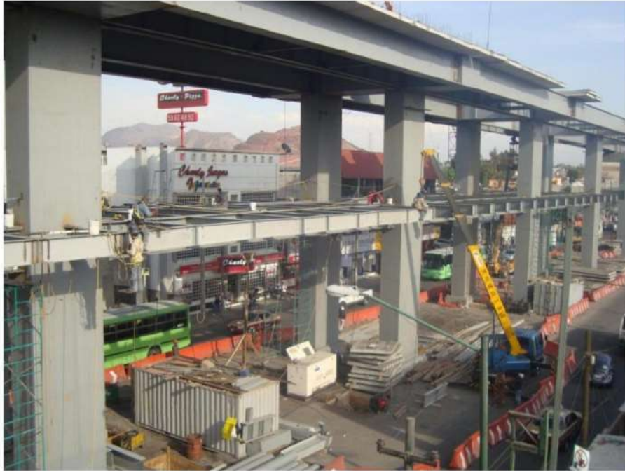
OBRA ACCESO SUR METRO LINEA 12 SECTOR PÚBLICO
