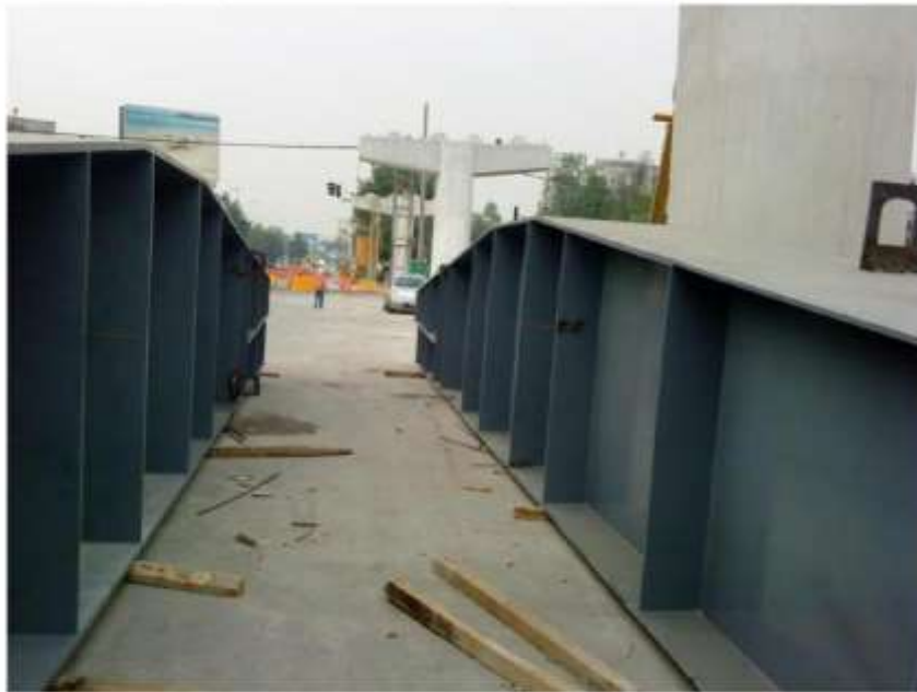
OBRA PUENTE VEHICULAR PERIFERICO SECTOR PÚBLICO
