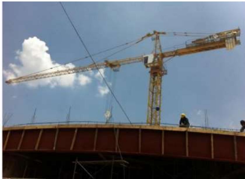
OBRA CETRAM SECTOR PÚBLICO
