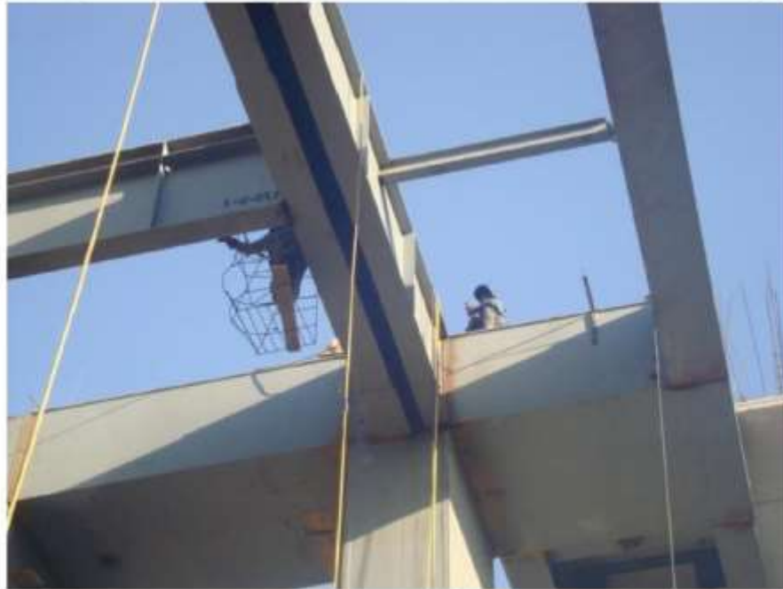
OBRA ACCESO SUR METRO LINEA 12 SECTOR PÚBLICO
