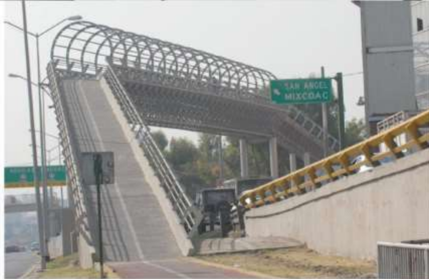
OBRA PUENTE BACO SECTOR PÚBLICO
