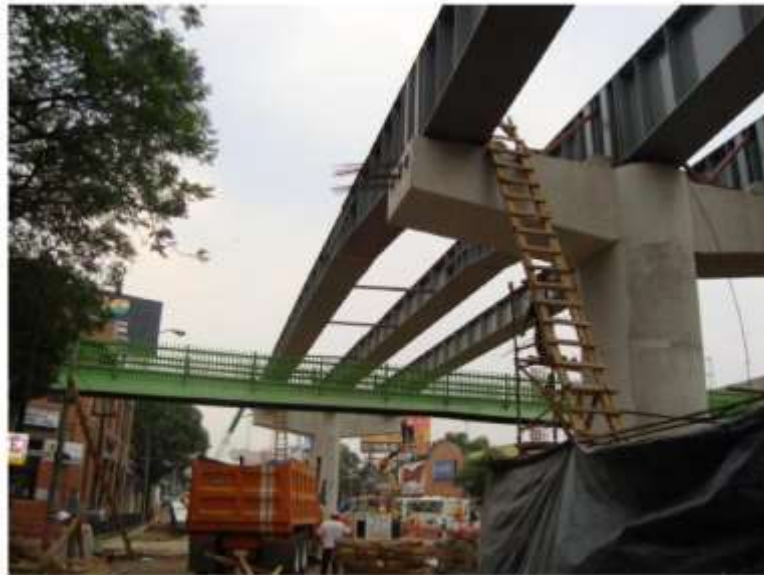
OBRA PUENTE VEHICULAR PERIFERICO SECTOR PÚBLICO
