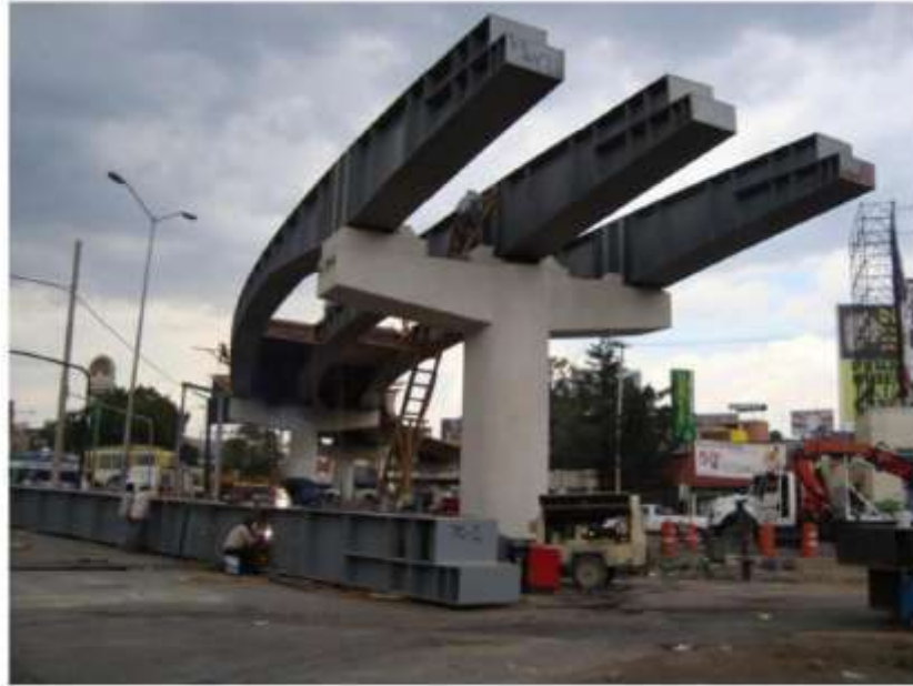
OBRA PUENTE VEHICULAR PERIFERICO SECTOR PÚBLICO
