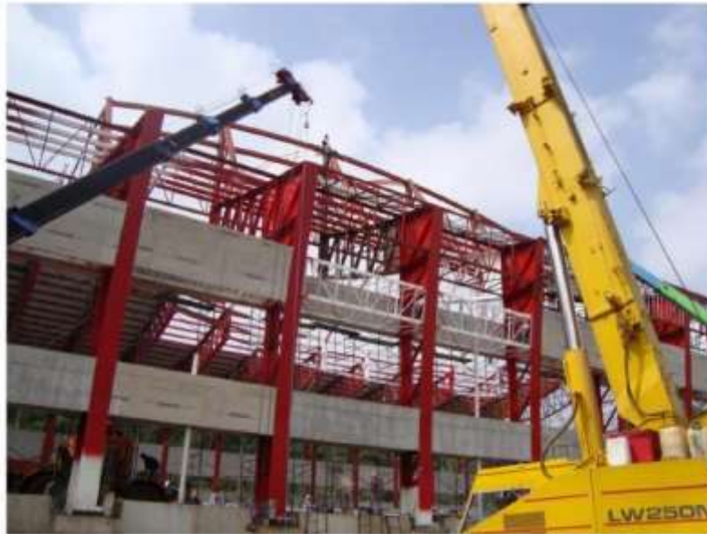
OBRA ALBERCA OLIMPICA SECTOR PÚBLICO
