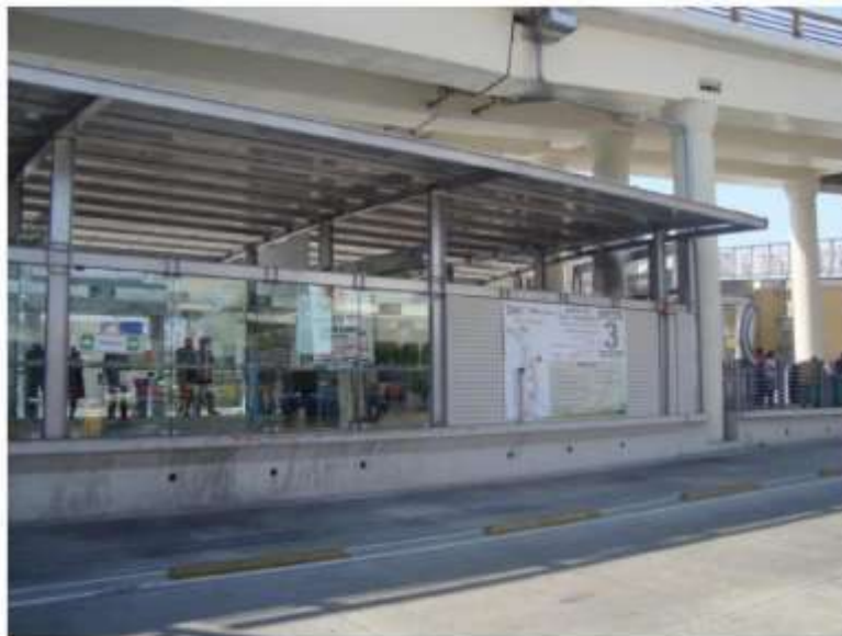
OBRA METROBUS SECTOR PÚBLICO
