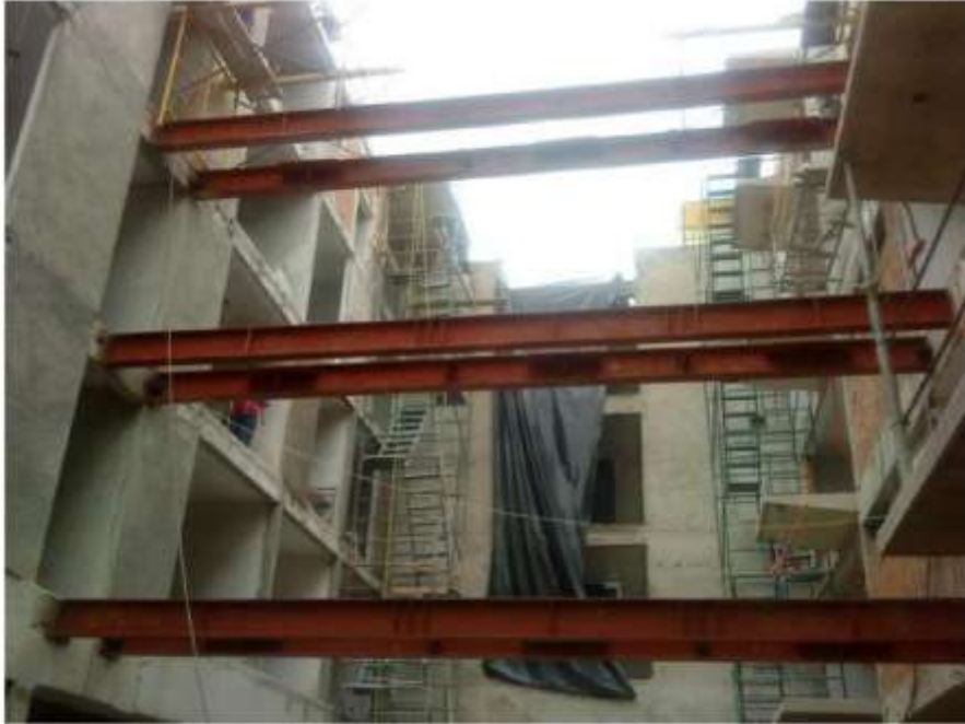
OBRA EDIFICIOS SECTOR PRIVADO
