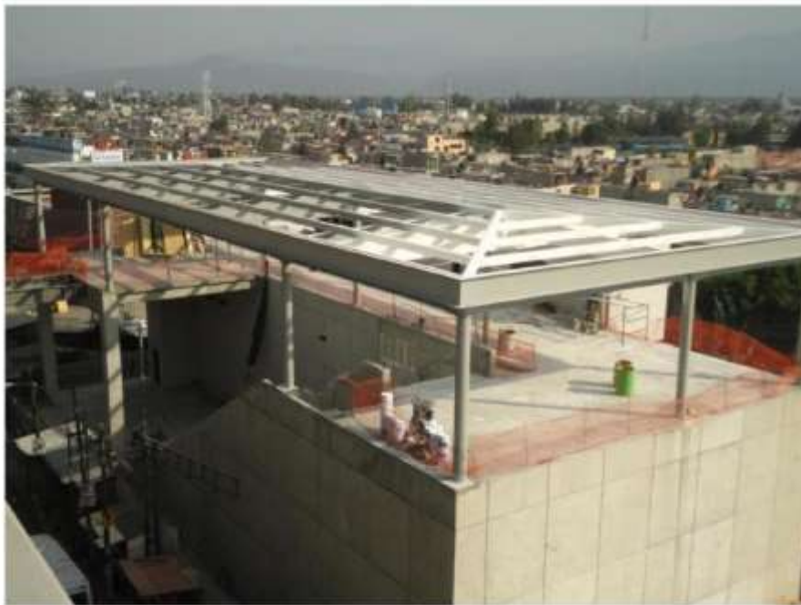
OBRA ESTACION PERIFERICO ORIENTE SECTOR PÚBLICO
