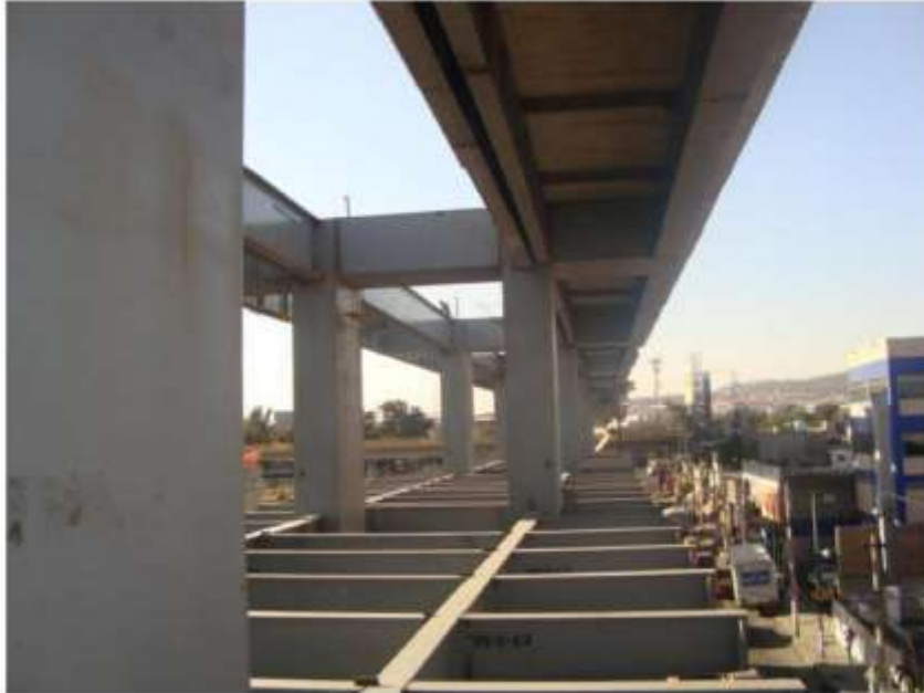
OBRA ACCESO SUR METRO LINEA 12 SECTOR PÚBLICO
