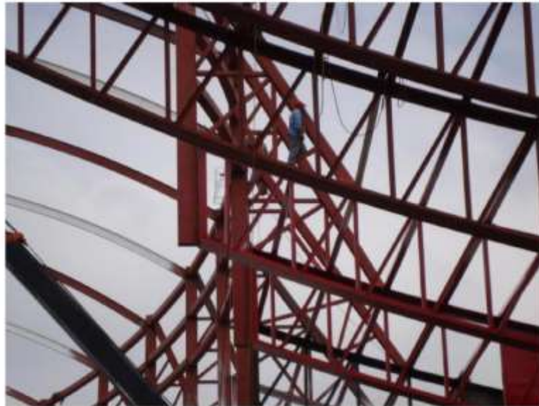
OBRA ALBERCA OLIMPICA SECTOR PÚBLICO
