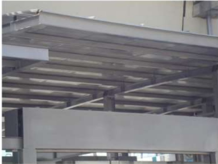
OBRA METROBUS SECTOR PÚBLICO
