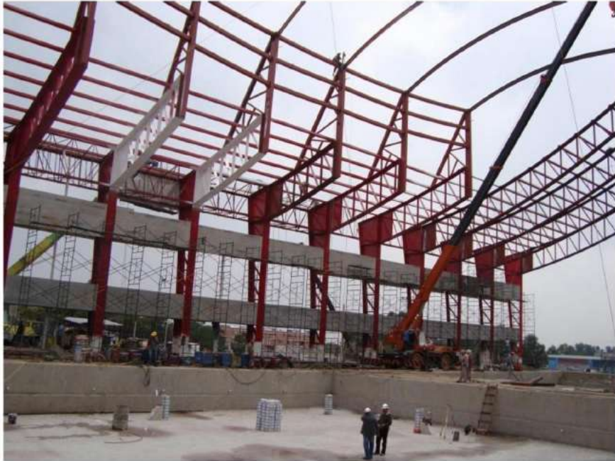
OBRA ALBERCA OLIMPICA SECTOR PÚBLICO
