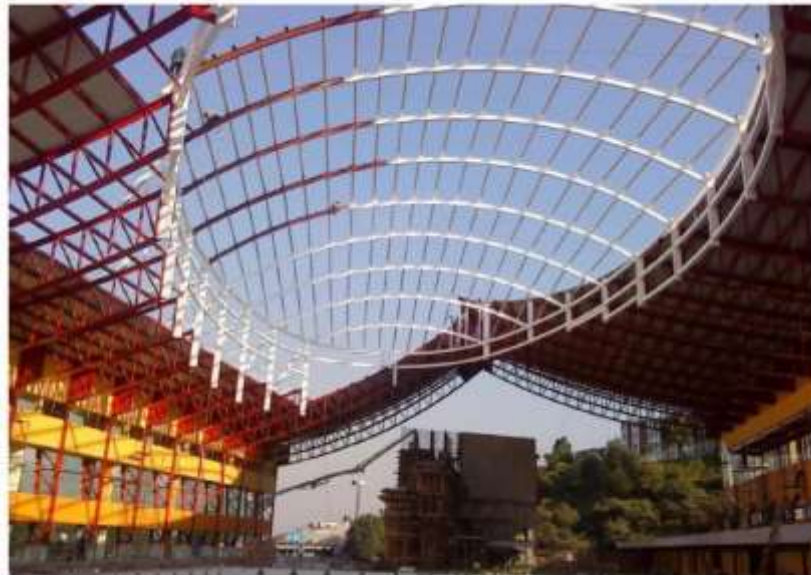
OBRA ALBERCA OLIMPICA SECTOR PÚBLICO
