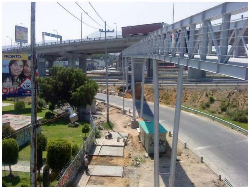
OBRA PUENTE PEATONAL SECTOR PÚBLICO
