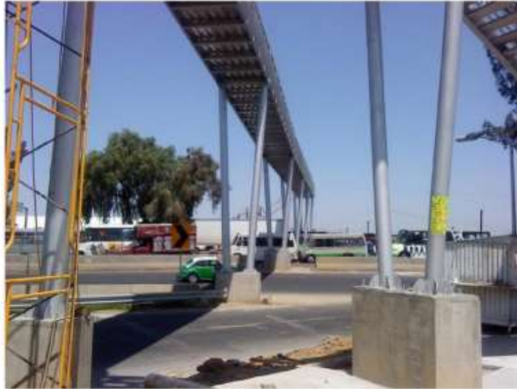
OBRA PUENTE PEATONAL SECTOR PÚBLICO
