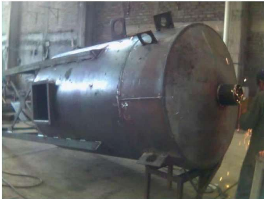
OBRA TANQUES SECTOR OTROS
