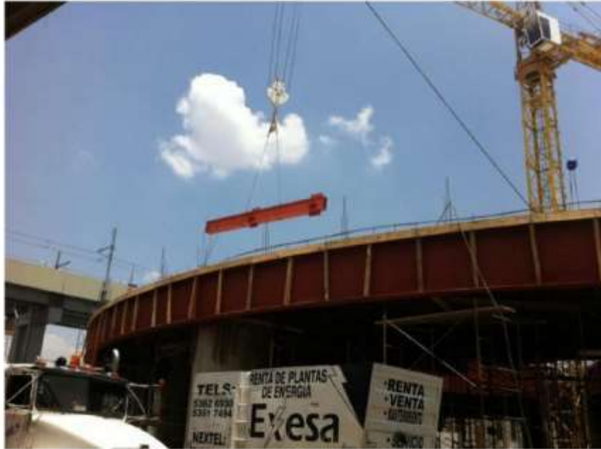
OBRA CETRAM SECTOR PÚBLICO
