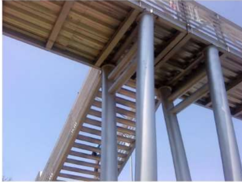
OBRA PUENTE PEATONAL SECTOR PÚBLICO
