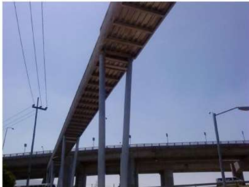
OBRA PUENTE PEATONAL SECTOR PÚBLICO
