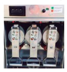
Sistema de disparo trifásico del seccionador bajo carga por fusión de un fusible.
