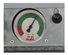
Manómetro con válvula de bloqueo (uno en cada función modular o uno por celda compacta).
