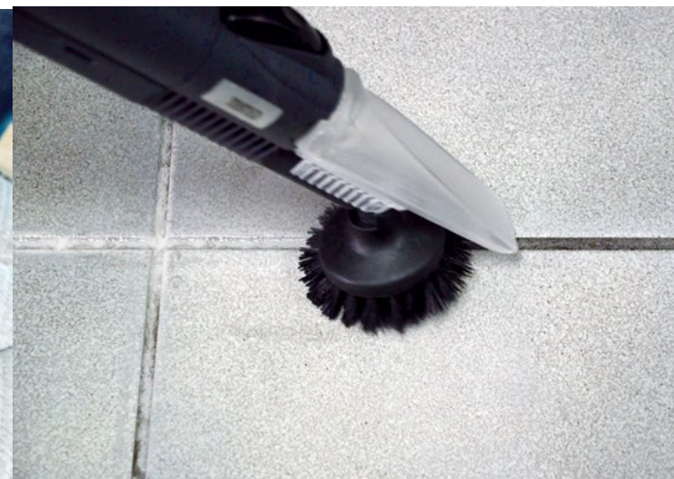
Cemento entre las Baldosas
