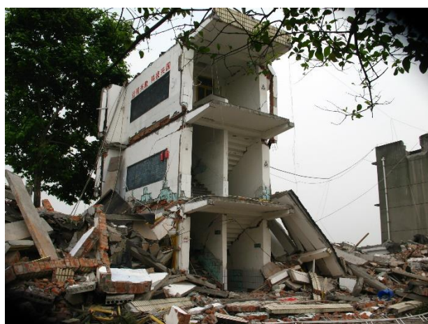
教学楼中间的楼梯间
