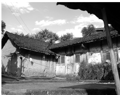
饥荒年建的疗养院（位于同心岛）
