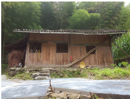
刚维修了的木板房
