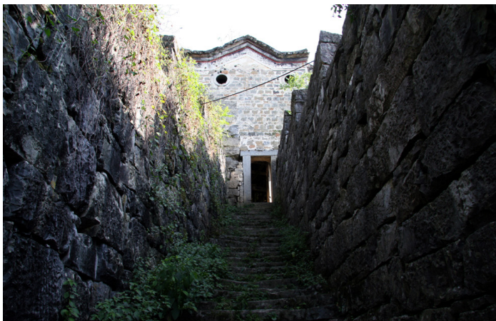
大水井取水处
