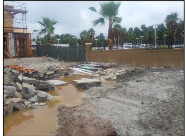
El mal manejo de las reservas se muestra arriba. Los montones de escombros de asfalto y concreto no fueron cubiertos y resguardados antes de un evento de lluvia.
