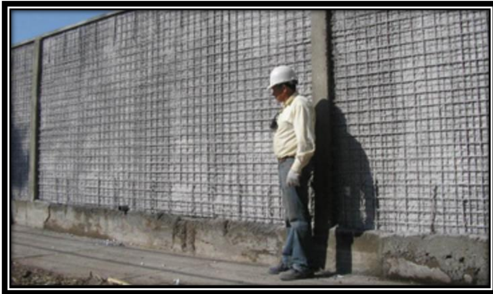
Figura 19. Imagen representativa de muro de Covintec. Fuente: COVINTEC, 2015.
