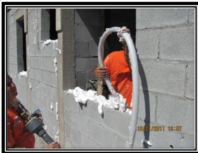
Figura 11. Imagen representativa de muro de block hueco con Aislante de polímero. Fuente: Proveedor.
