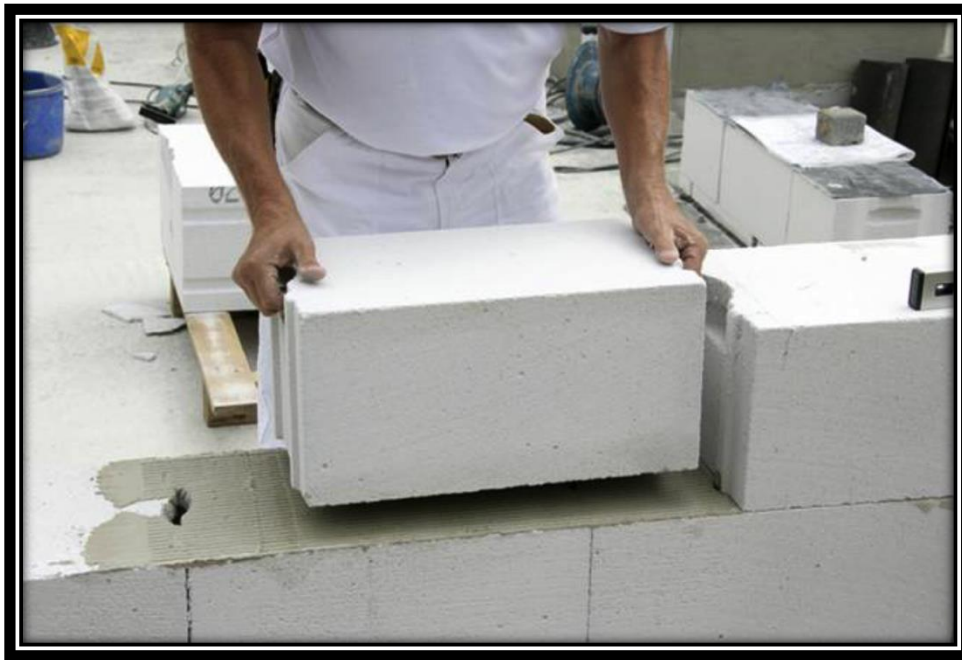
Figura 17. Imagen representativa de un muro de block de concreto celular. Fuente: Grupo XELLA, 2015.
