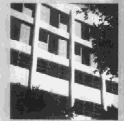
عمارة كامل لهيطة بور سعيد Lehita Building Port Said 1960
