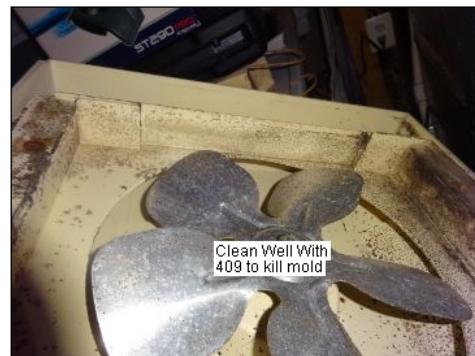
Humidifier System Fan
