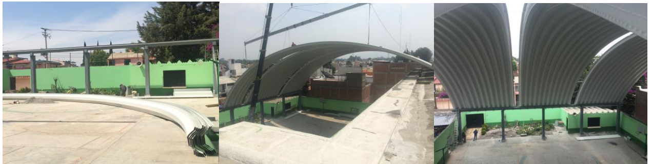
DESARROLLO DE INFRAESTRUCTURA ICG, S.A. DE C.V REFORZAMIENTO Y ESTRUCTURA METALICA NUEVA EN NIVEL 22 Y 23, ASI COMO ARMADURAS EN NIVEL 24 DE TORRE SECRETARIA DE ECONOMIA CIUDAD DE MEXICO..
