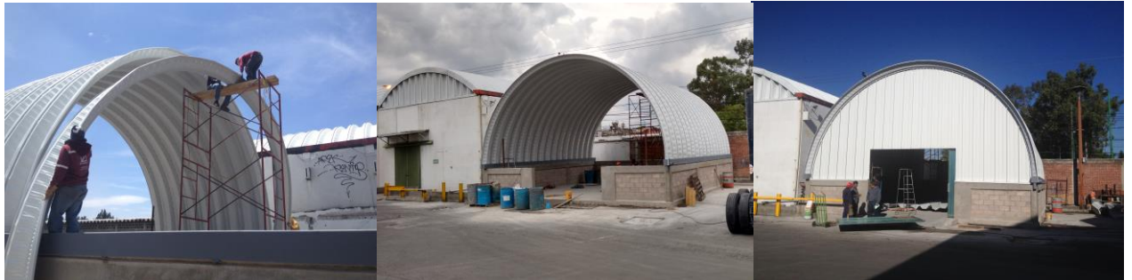
COLEGIO DOMINGO DE GUZMAN COLOCACION DE ESTRUCTURA METALICA Y ARCOTECHO EN AREA DE USOS MULTIPLES. CIUDAD DE MEXICO
