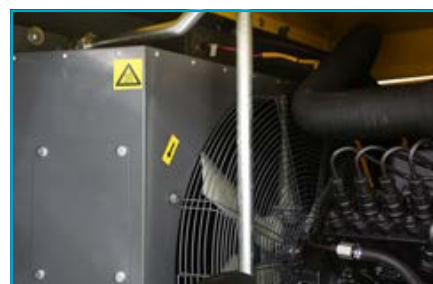
Sistema de refrigeración mejorado para una temperatura ambiente elevada de 50 °C.
