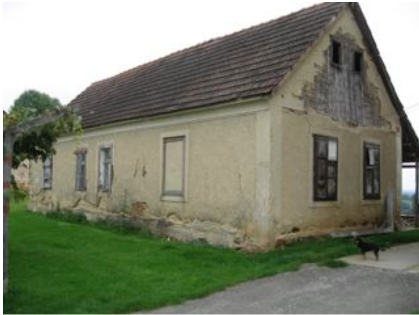
35. Foto des Gebäudes der ehemaligen Schneiderei Fritz in Ocinje, aufgenommen im Jahr 2010.
