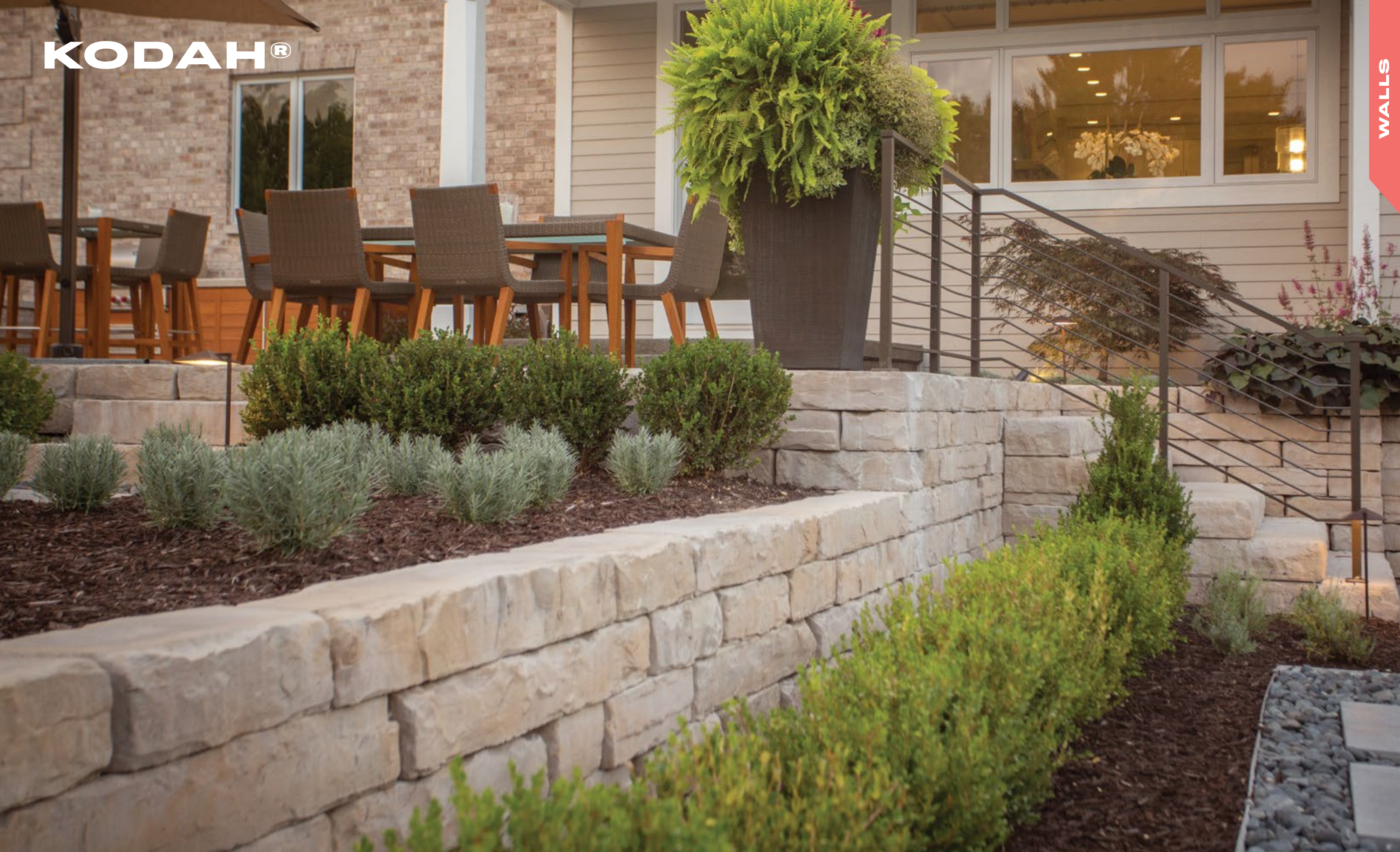
Kodah® Wall in Fond Du Lac
