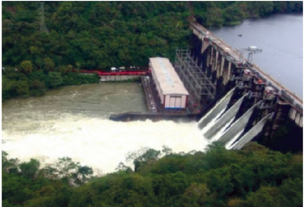
Hidroeléctrica de Bayano
