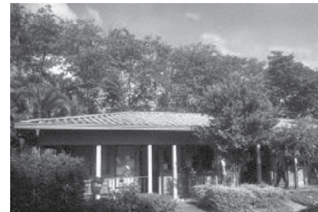
Foto 1. Fachada en el bloque occidental
