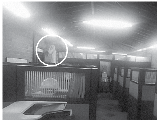
Foto 9. Ubicación de ventilador en Gestión Ambiental 1 Fuente: SMA Envigado, 2020.
