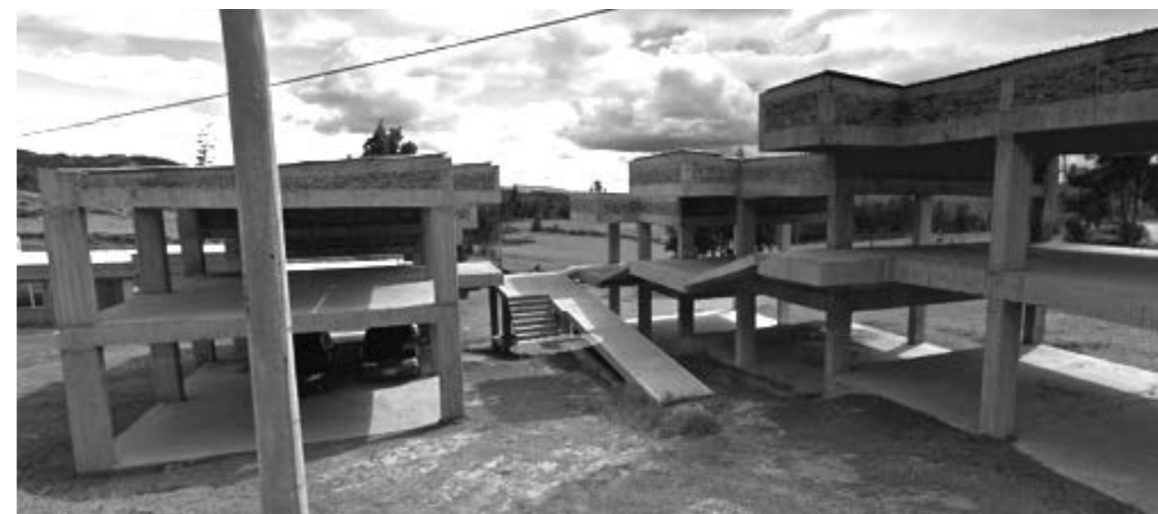
Foto 14. Estructura desnuda del bloque de Aulas 3
