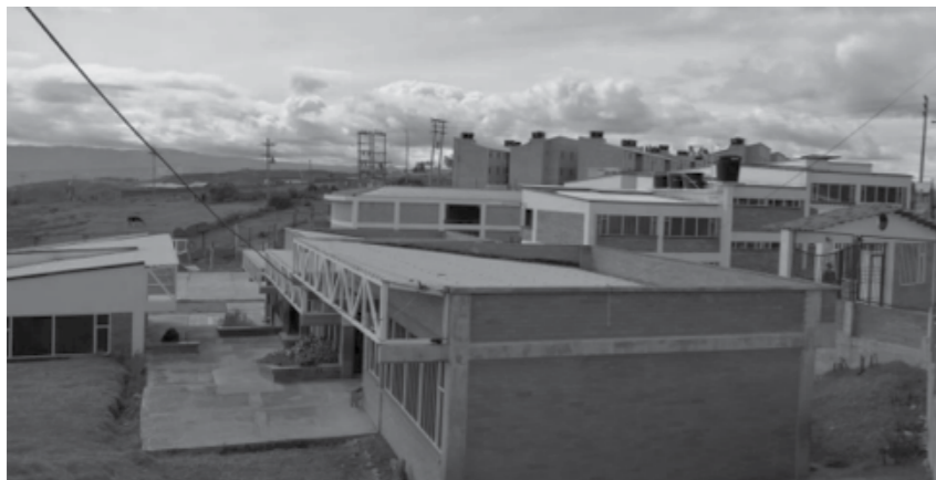
Foto 4. Bloques vistos desde la esquina suroriental del prédio
