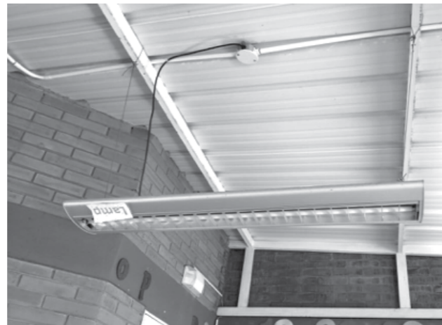
Foto 16. Techo donde se aprecia subestructura y tejas trapezoidales
