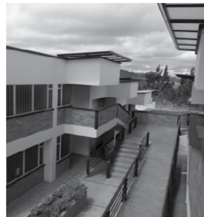
Foto 5. Bloque de aulas 1
