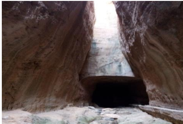
Foto 2: Samandağ ilçe merkezine 5 km mesafede, Çevlik mahallesinde yer alan Titus Tüneli, sel sularının, yüksek dağlık alanlardan taşıdığı malzemelerin limana akmasını önlemek ve liman dışına akaçlamak için M.Ö. 300 yılında yapılmıştır. Yüksekliği 7m, genişliği, 6m uzunluğu ise, 130m. olan tünelin açık alandaki uzunluğu ise, 1380 m'dir
