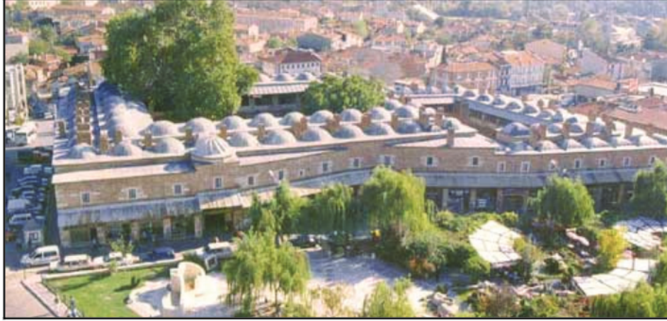
Resim 3: Rüstem Paşa Kervansarayı
