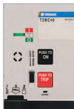
Interruptor en posición TRIP (disparado)
