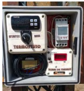
Figura 1. Controlador de aireación utilizado en el ensayo. El detalle de componentes incluye un termostato (arriba a la izquierda), un contador de horas de funcionamiento (abajo a la derecha) y un temporizador (arriba a la derecha).
