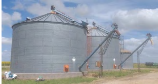
Figura 2. Silos A y B de 500 t utilizados en el ensayo.
