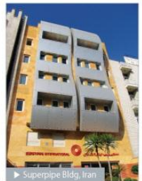
► Superpipe Bldg, Iran
