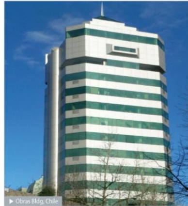
► Obras Bldg, Chile
