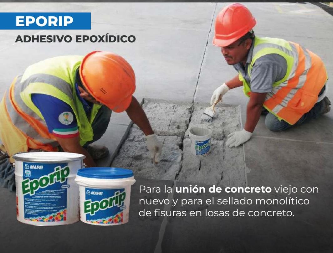
Para la **unión de concreto** viejo con nuevo y para el sellado monolítico de fisuras en losas de concreto.
