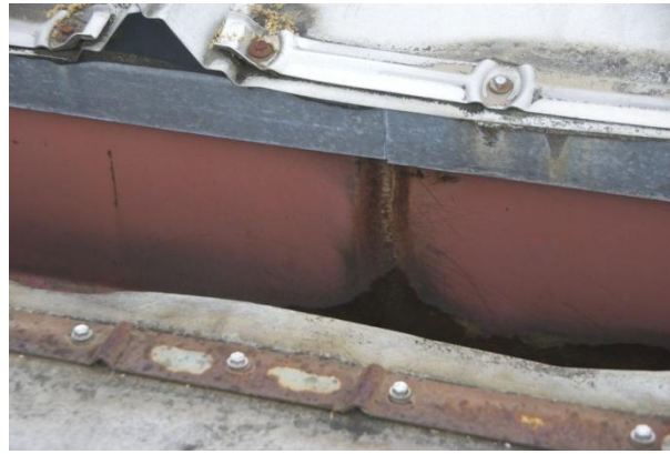
(d) Plated carbon steel at 31 years
