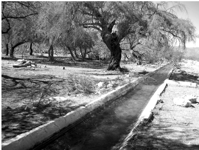
Canal actual que trasporta el agua del Ojo de agua de Sardinias. 2010.
