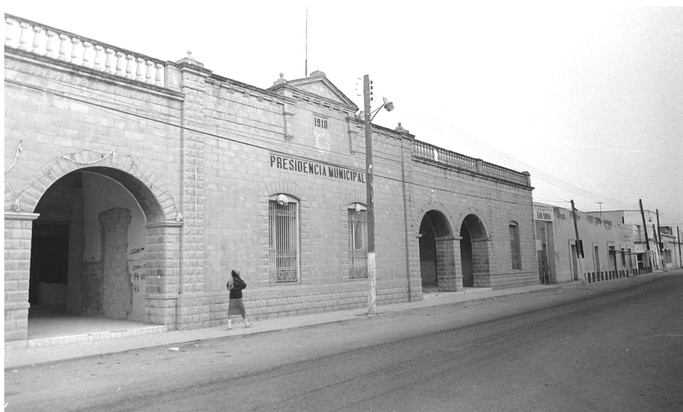
Presidencia municipal durante su reparación y rehabilitación - Circa 1980.
