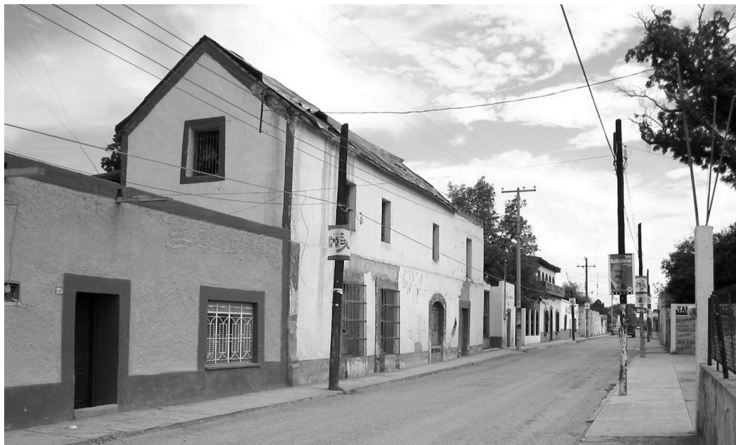
Molino San Buenaventura Rivera y González. Demolido en 2012.
