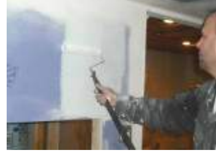
Applying primer to new drywall.
