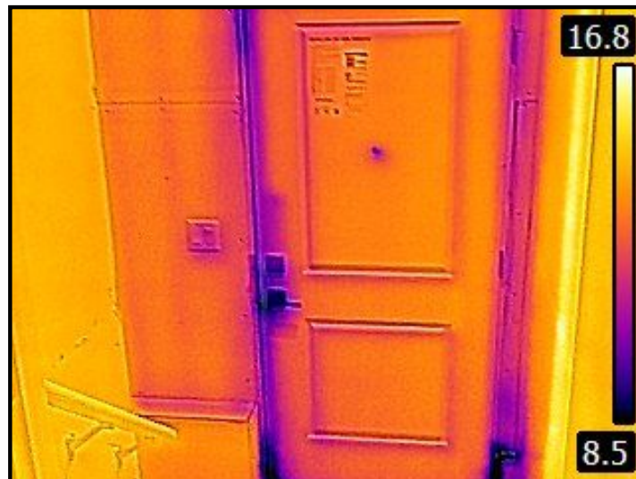
Side Entryway - Thermal Image
