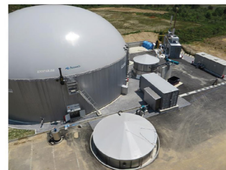
Planta de biogás en Asia del Este Sustrato: Desechos alimenticios, pasto, cereales, residuos de separadores de grasa. Capacidad eléctrica: 370 kW
