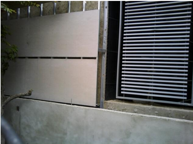
Fachada preparada para Dilatación U 5 cm
