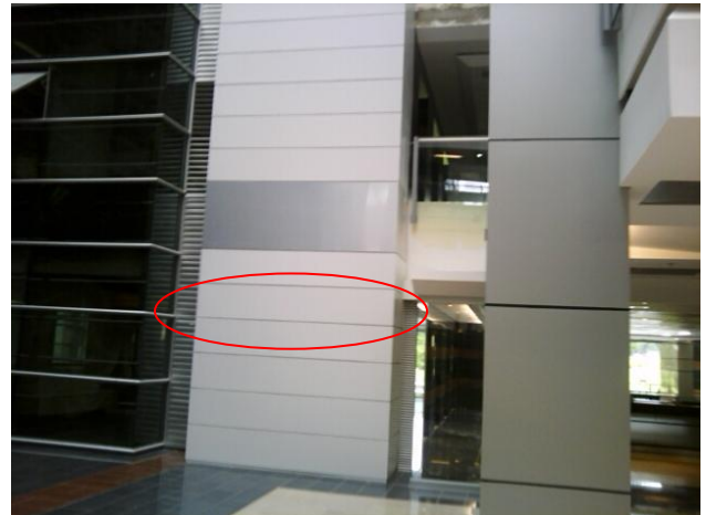
Fachada Interna con Dilatación U 5 cm
