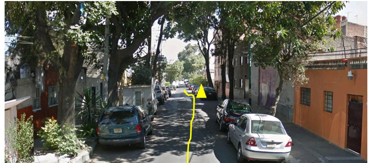
Ilustración 23. Subsistencia en la calle de Filipinas y Santa Cruz. Triángulo representa punto menos hundido.
