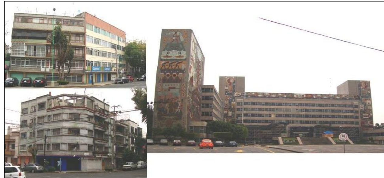
Ilustración 28. Edificaciones desplomadas (izquierda) y dañadas en sismos.
