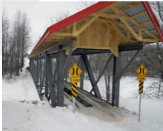
Passerelle de motoneiges, Amqui, Canada
