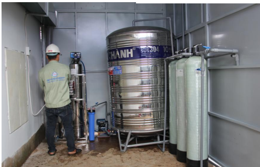
4/8/2018, hệ thống lọc công nghệ Nhật Bản với công suất 4.000 lít/ngày cho sản phẩm nước khoáng được lắp đặt và được lấy mẫu nước để xét nghiệm tại viện Pasteur Sài Gòn
