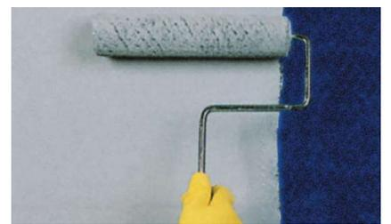
6. Repita la aplicación de capas de saturante-fibras-saturante según sea necesario. Aplique Master Brace® Topcoat (opcional).
