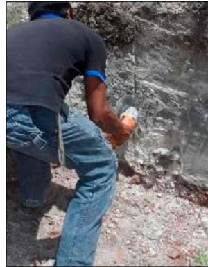
Figura 13. Utilizar la cortadora con disco de diamante.
