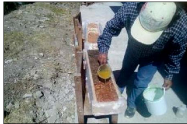
Figura 27. Impregnación con laca.
