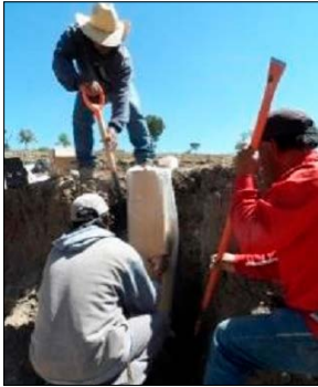
Figura 22: Desprendimiento del monolito.
