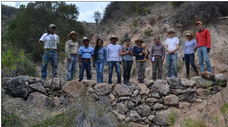
Figura 7. El camellón está terminado para recibir las primeras lluvias.
