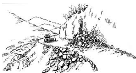
[C1] Caída de rocas. Carretera de Teloloapan a Iguala, Gro, 1937.
