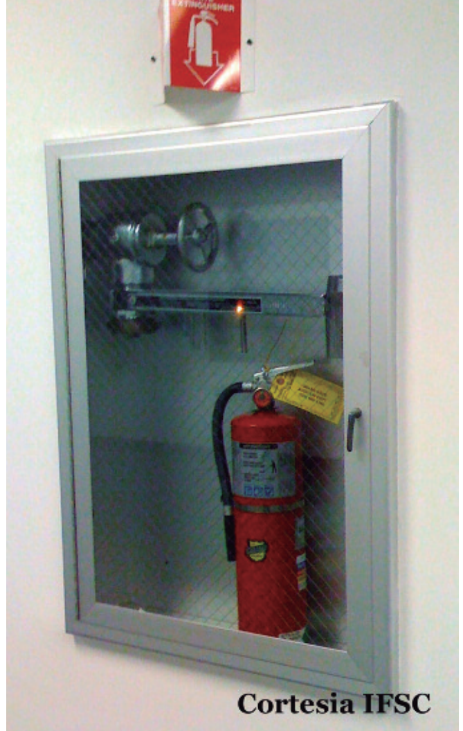
Foto 2. Gabinete de manguera donde se ha retirado la manguera y se ha dejado la conexión para bomberos (Foto cortesía IFSC).
