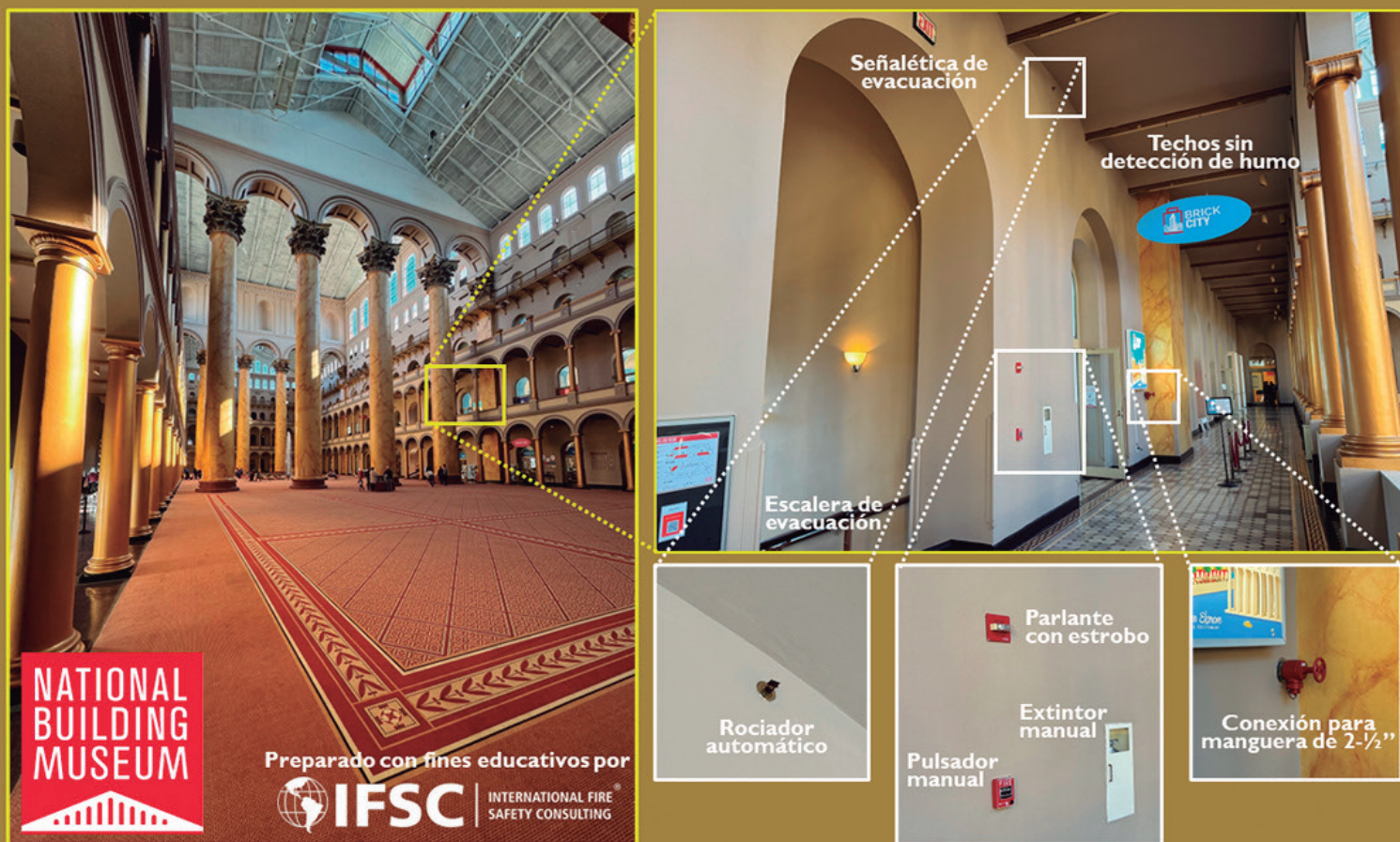
Protección contra incendios típica de un edificio grande de acuerdo con NFPA: Construcción resistente al fuego, vías de evacuación señalizadas, rociadores automáticos, sistema de alarma con pulsadores manuales y notificación por voz con estrobos, extintores, y conexiones para mangueras Clase I (Fotografía cortesía de IFSC).
