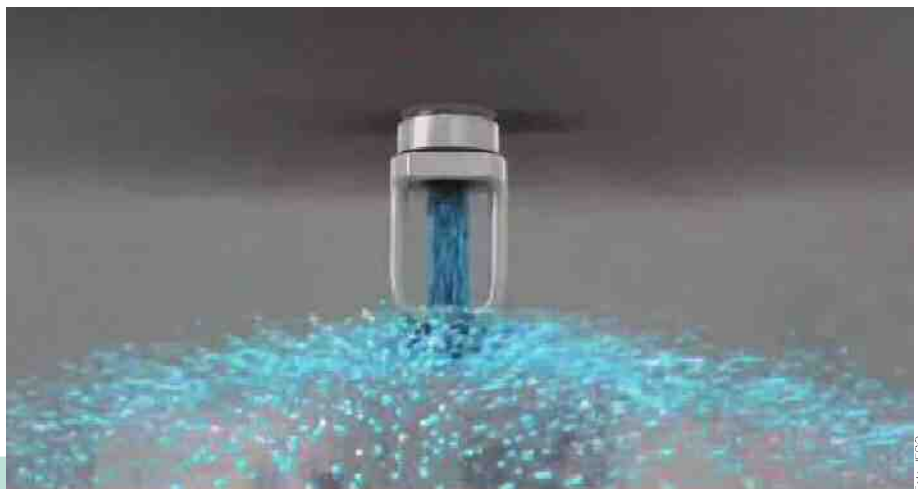
Rociador que ha operado por el calor del incendio
