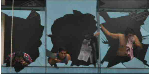
Ocupantes de la Torre A esperando rescate por parte de los bomberos
