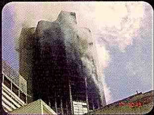
10:49am-El avance vertical del fuego es temporalmente detenido por la Macrolosa 4
