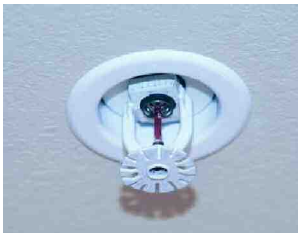
Rociador pendiente semiembutido de respuesta rápida
