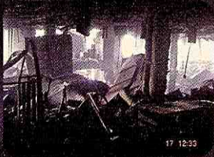
12:33pm-Los bomberos que se retiran del edificio, toman una foto de un colapso parcial en el piso 35
