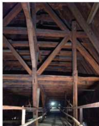
Ático de madera que soporta el techo de la Catedral es llamado "El Bosque" por los que trabajan allí.
