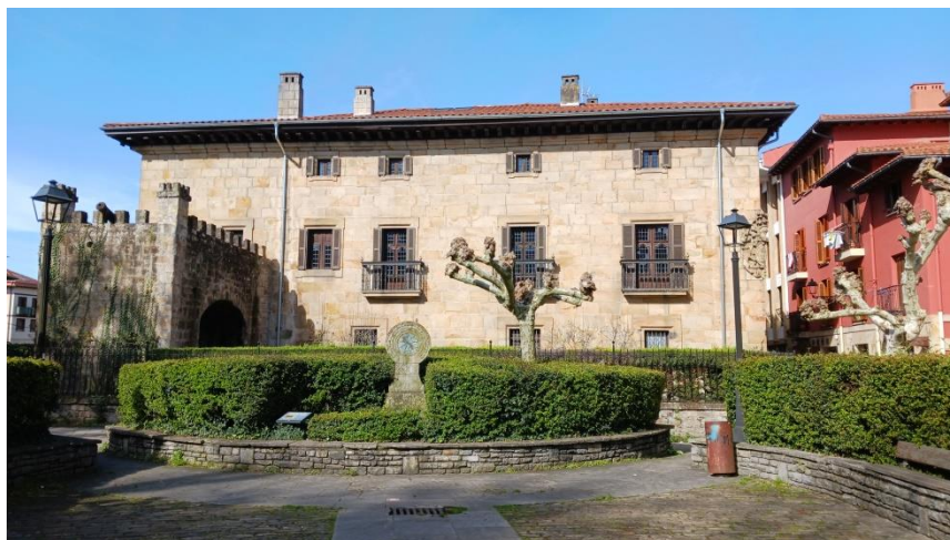
El Portal del Campo y el palacio de Arespacochaga
