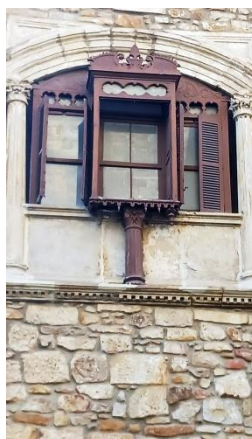
Detalle de una ventana
