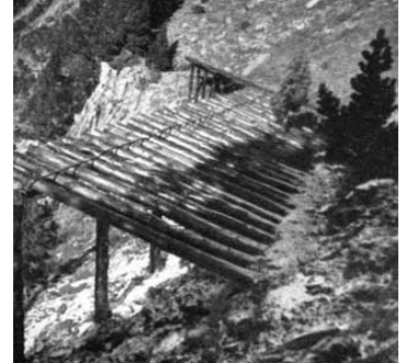
Diversas obras de repoblaciones forestales, diques de retención de sedimentos para corrección de torrentes, diques vacíos y diques rastrillos para retención de aludes en la estación de Canfranc
