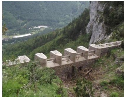
Diversas obras de repoblaciones forestales, diques de retención de sedimentos para corrección de torrentes, diques vacíos y diques rastrillos para retención de aludes en la estación de Canfranc
