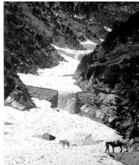
Diversas obras de repoblaciones forestales, diques de retención de sedimentos para corrección de torrentes, diques vacíos y diques rastrillos para retención de aludes en la estación de Canfranc
