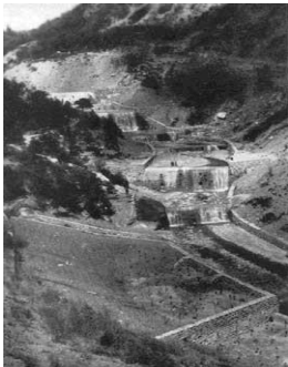
Diversas obras de repoblaciones forestales, diques de retención de sedimentos para corrección de torrentes, diques vacíos y diques rastrillos para retención de aludes en la estación de Canfranc
