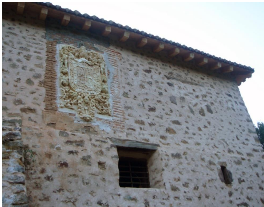
La casa del "Solar de Tejada" con su escudo
