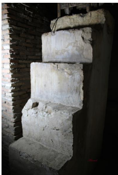
Escalera de bajada a la cripta
