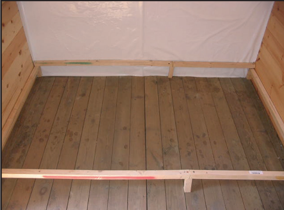
Construimos paredes que sean de un blanco reflectante y una bandeja de recogida de restos. Hacemos una construcción de madera de unos 15-20 cm.
