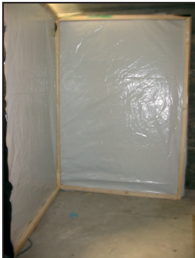
Para obtener el máximo rendimiento de nuestro metro cuadrado, construimos una pantalla reflectante alrededor. De esta manera, controlamos mejor el clima y creamos un ambiente totalmente resistente a la luz.
