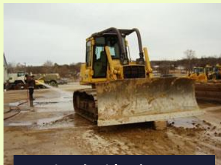
Recirculación de aguas de lavaderos
