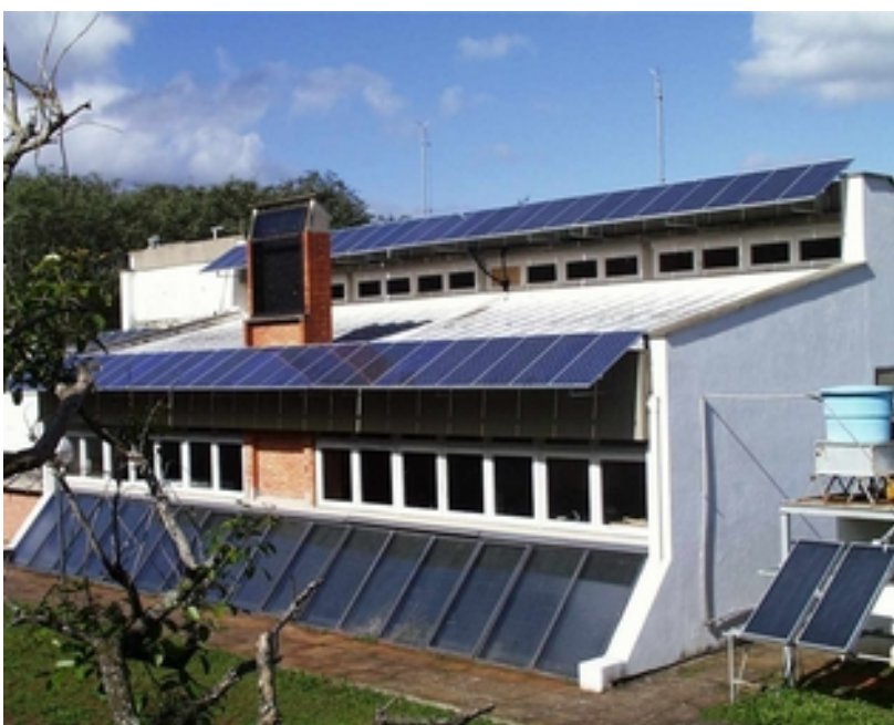
Figura 5. Prédio do Laboratório de Energia Solar, LABSOL, da UFRGS onde podem ser visto os módulos fotovoltaicos que integram o sistema conectado à rede de 4,8 kWp implantado no ano de 2004. Fonte: LABSOL, UFRGS.
