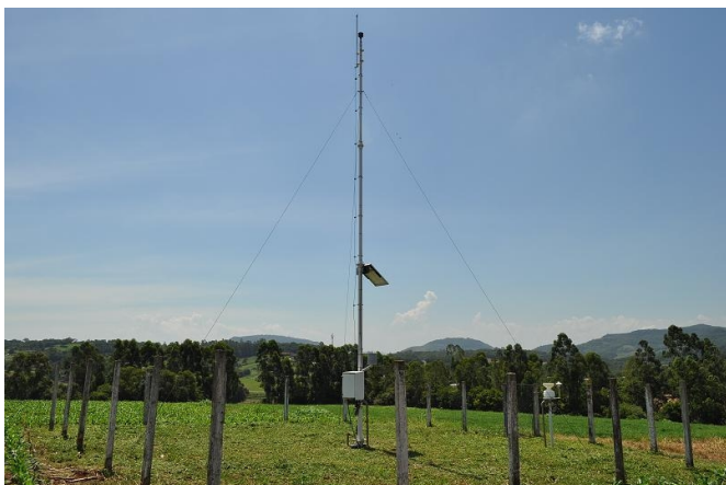
Figura 18. Estação Meteorológica Automática do INMET básica instalada na cidade de Teutônia, RS. Fonte: INMET
