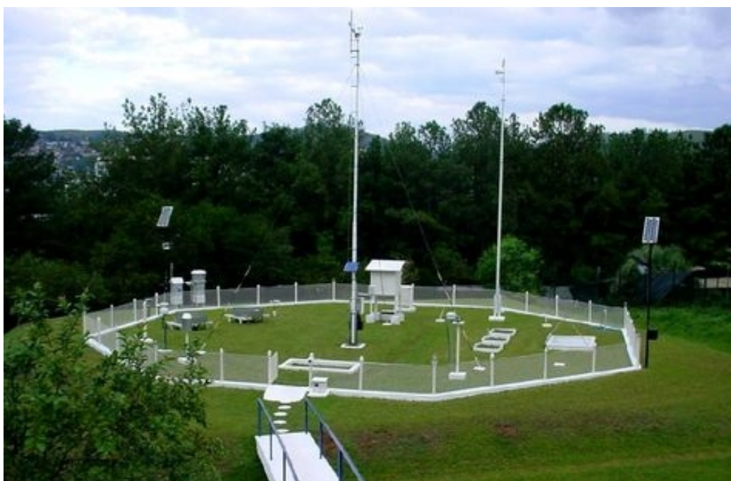
Figura 19. Estação Meteorológica Automática do INMET instalada na cidade de Porto Alegre. Fonte: INMET.
