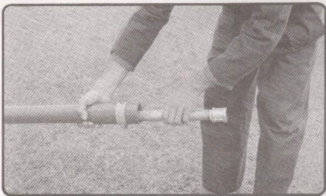
SOSTENGA LA CAMISA FIRMEMENTE MEDIANTE LAS TIRANTAS; ASEGURE EL TUBO GALVANIZADO CON UNA CUERDA PARA IMPEDIR QUE PUEDA CAER TOTALMENTE DENTRO DE LA CAMISA Y ENRÓSQUELO EN LA UNIÓN INFERIOR DEL CABEZAL.
