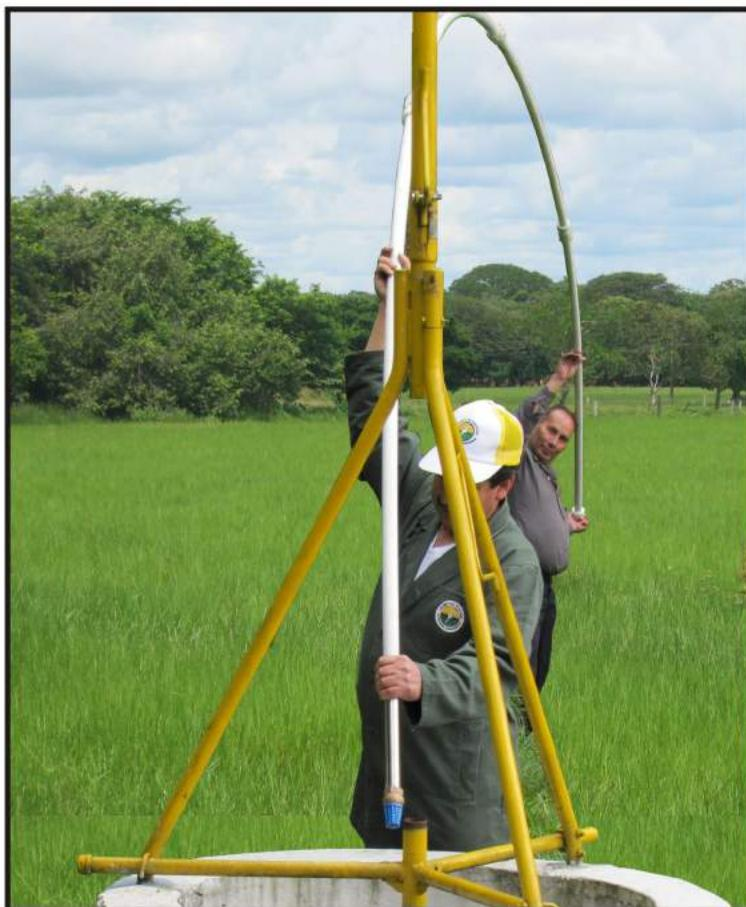
*CURVANDO CON SUAVIDAD EL TUBO INFERIOR, SE INTRODUCE EN EL POZO EL CONJUNTO FORMADO POR:*
