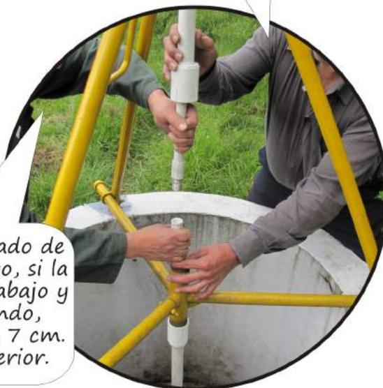
El tiro viene calibrado de fábrica, sin embargo, si la biela se encuentra abajo y el pistón toca fondo, deben quedar unos 7 cm. de luz al tiro superior.
