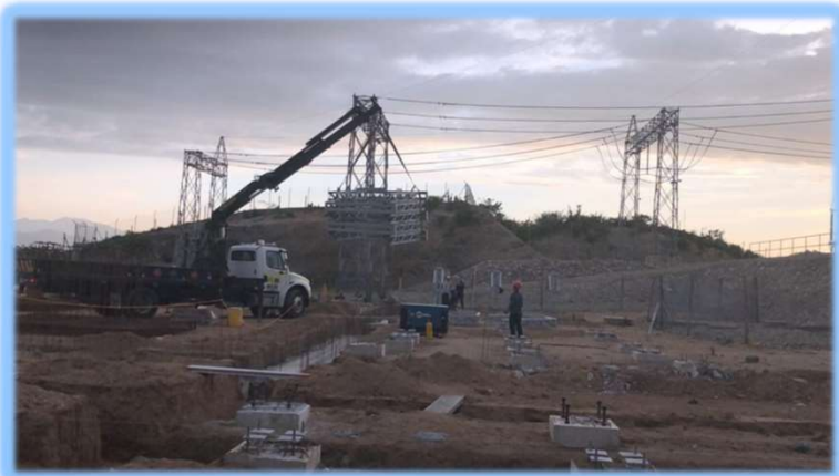
Obras civiles generales y fundida de muros cortafuegos de 8mts de altura, para zona de Transformadores.
