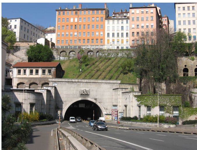
Tunnel routier de la Croix-Rousse à Lyon – France 2013. 1 tube neuf et 1 rénové d'une longueur de 1782m chacun.
