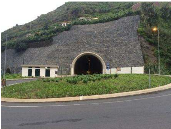
Tunnel de la Variante da Madalena phase 2, Ile de Madeire 2017 1 tube de 1535m
